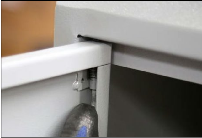
Illustration: Unhinging the switch box door
