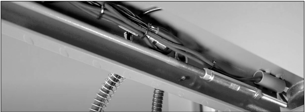
Figure : Câble sous la chaussée
