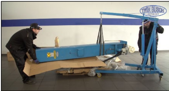
Figure : Déplacement de la colonne avec une grue motorisée
