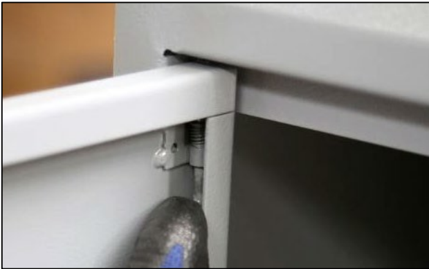
Illustration : décrochage de la porte du boîtier électrique
