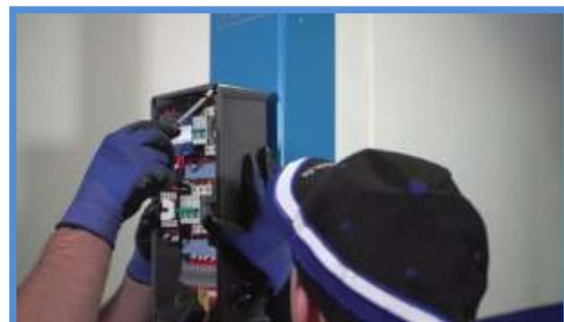
Afin de garantir le fonctionnement optimal du fin de course, il est nécessaire de le préconfigurer légèrement. Desserrez pour cela la vis permettant de régler le bras coulissant et sortez ce dernier en le faisant coulisser.
